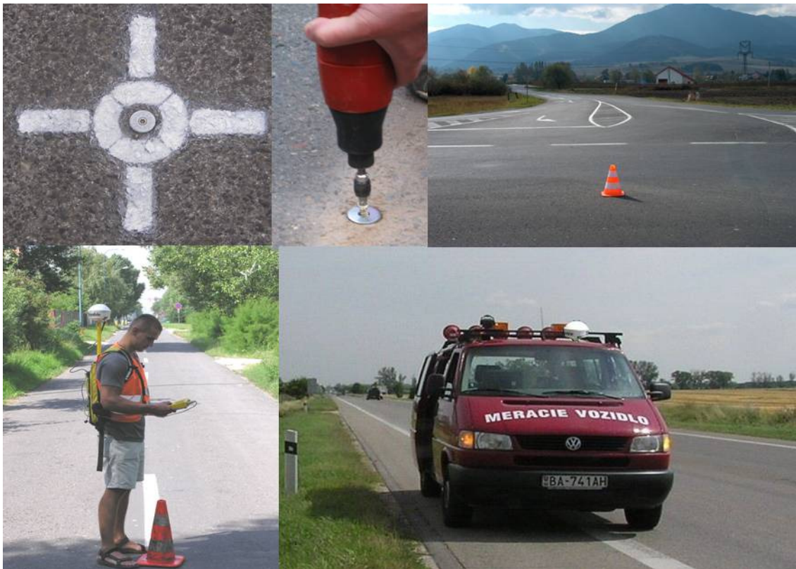
Obr. 2 Zber referenčných dát technológiou GPS, stabilizácia a vyznačenie uzlového bodu
