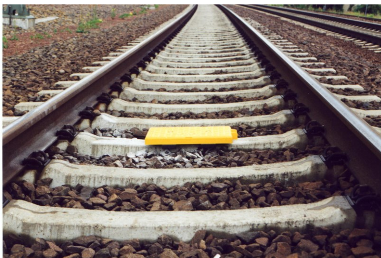
Obr. 1 Balíza umístěná na trati (zdroj: vde8.de)
