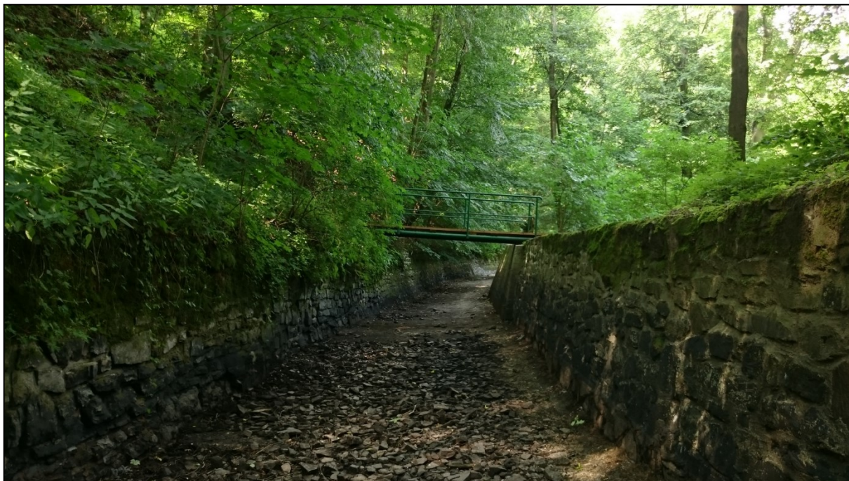
Obr. 9. Suché koryto Žimrovického náhonu u hydrometrického profilu č. 1.
